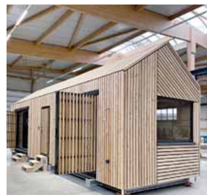
Präzision aus der Werkhalle: Die »Tinca Cabins« werden vollständig vorgefertigt und schlüsselfertig geliefert.
